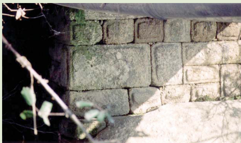
Fig.1a e 1b - Dois pormenores do intradorso do pilar direito da ponte romana sobre o rio Sousa, em Barrimau (Aveleda). Fotografias do Mestre Miguel Rodrigues.
