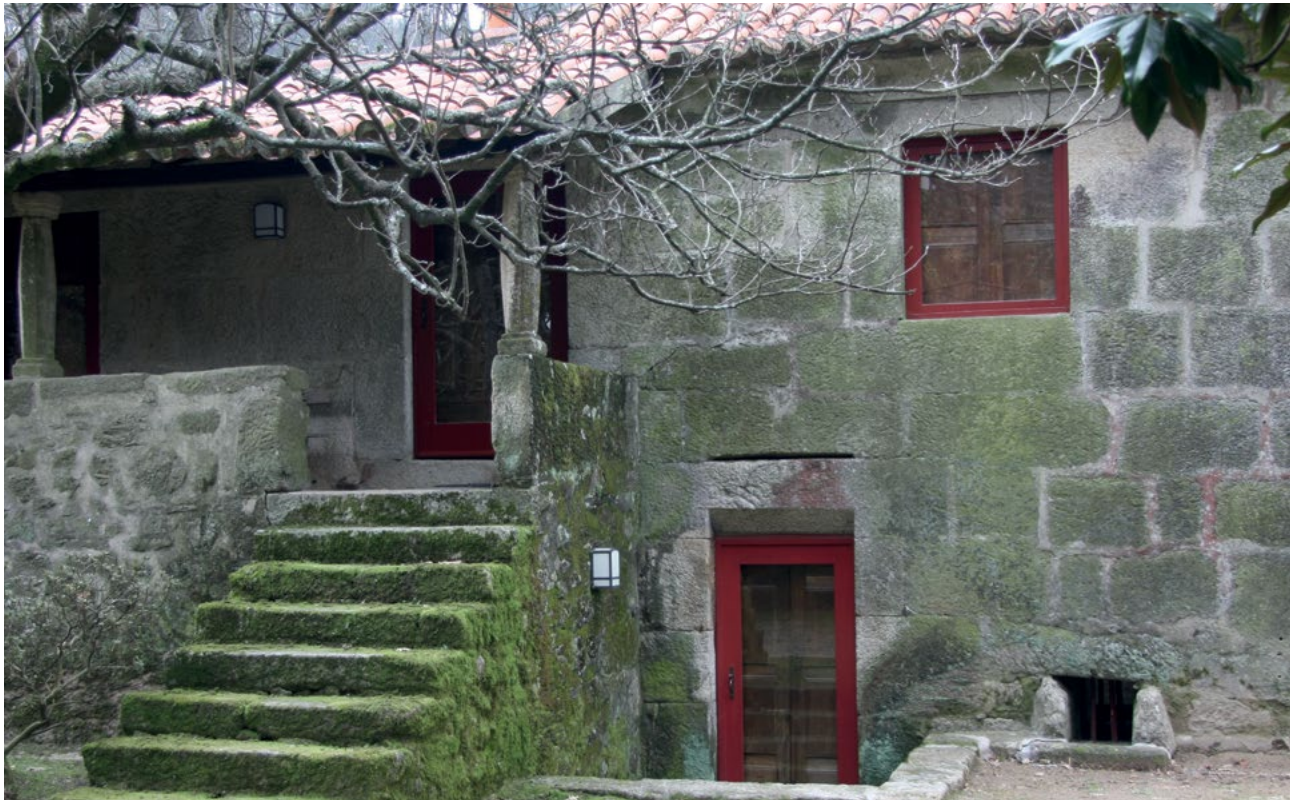
Figura 2. Aspeto parcial da fachada principal da Casa de Além e terreiro contíguo.
