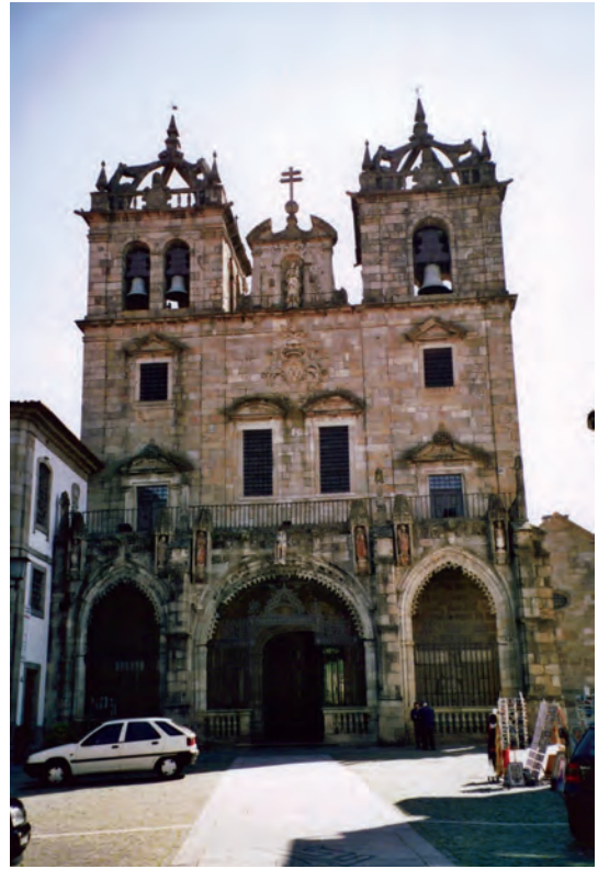
Figura 6. Fachada da entrada na Catedral tal como é vista a partir da Praça do Pão, sendo visíveis o nártex e as sete estátuas do início do séc. XVI.
