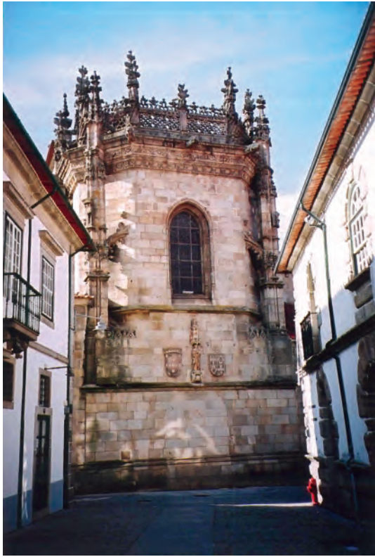
Figura 5. Vista da capela-mor da Catedral do início do séc. XVI a partir da Rua São Marcos.
