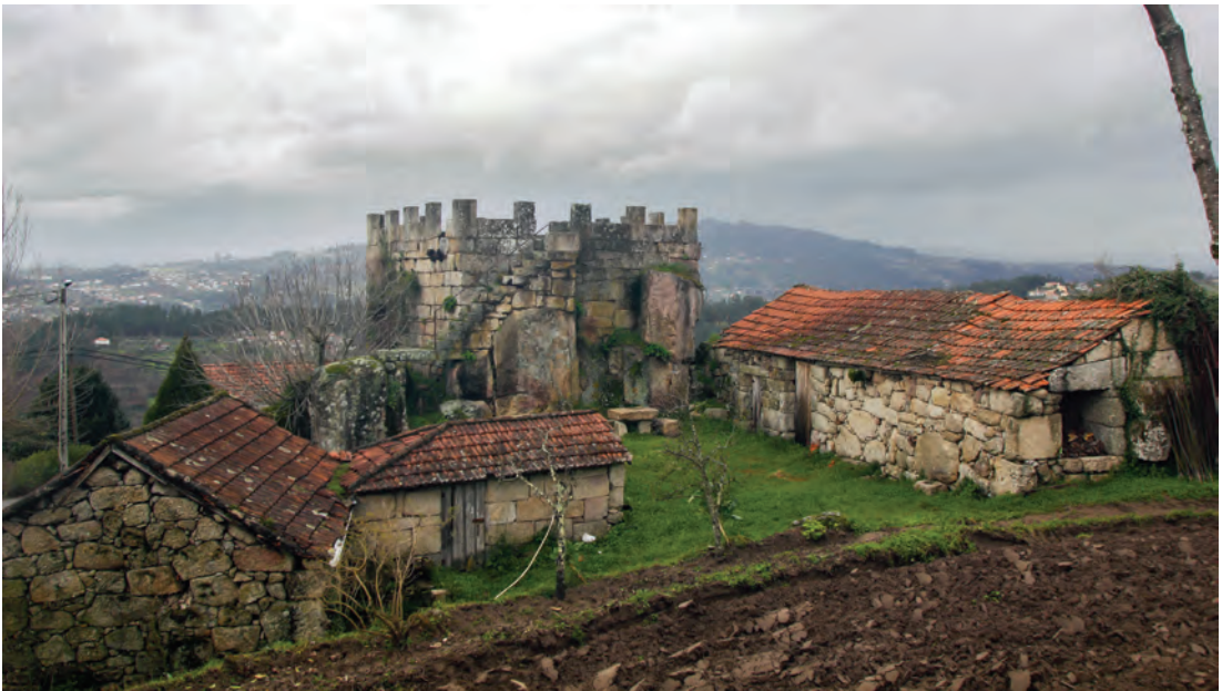
Figura 2. Perspetiva geral da Torre da Pena e construções anexas
