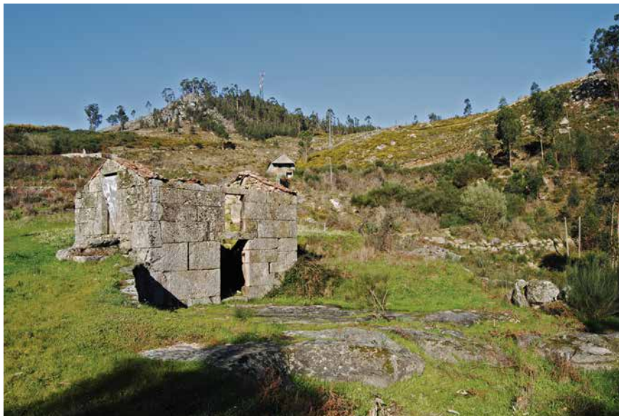
Figura 8. Aspecto atual do beiral da Tapada de Eiró e afloramentos correspondentes à eira onde se encontram os gravados de Monte Eiró II.
