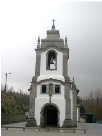
Figura 1 - Torre sineira que compõe a fachada principal.
