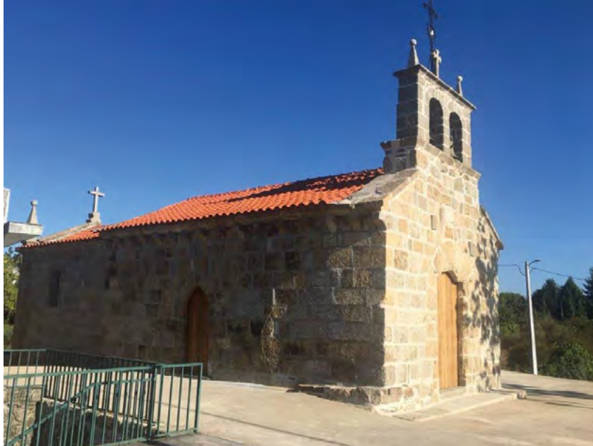
Figura 1 Aspeto geral da igreja de São Miguel.
